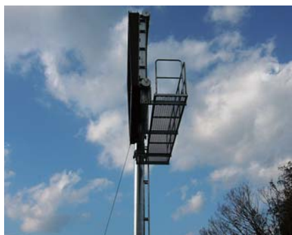
写真-6 筐体薄形化の例
