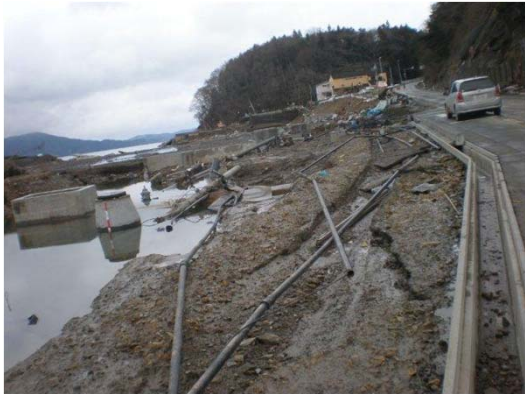
【R45 気仙大橋付近】 気仙町部望心 情報管路被害 (三陸国道(事))
