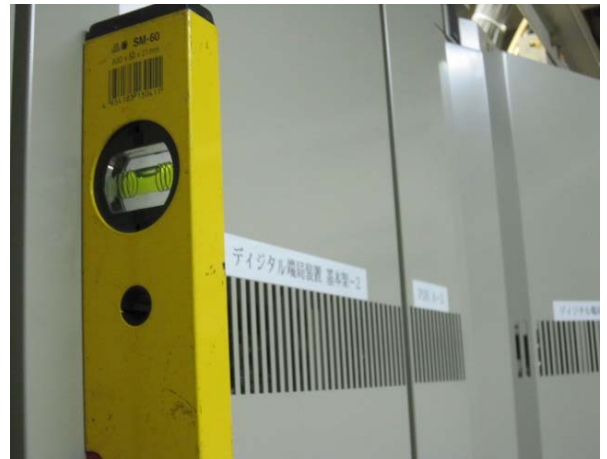
装置架列の水平状況に異常なし
