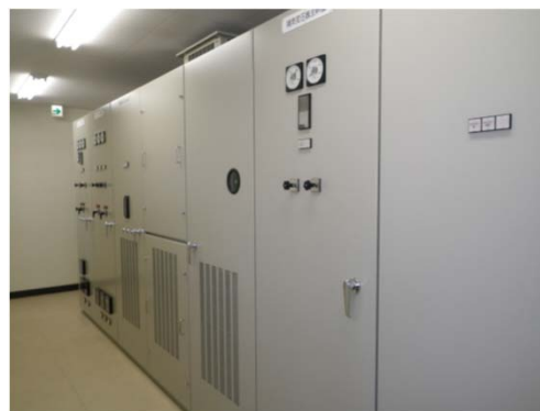
【新仙人トンネル】 異常なし
