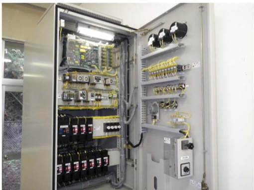
【北上大堰】 外観、盤内機器類に異常なし
