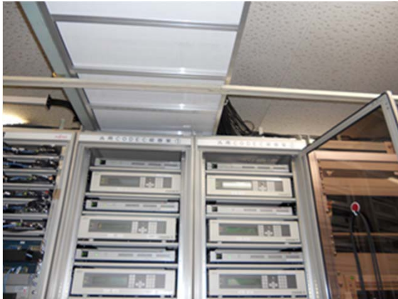
【東北地整 本局（仙台局）】 汎用CODEC收容：上下固定により異常なし
