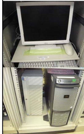
サーバ等が耐震固定されていないもの有り
