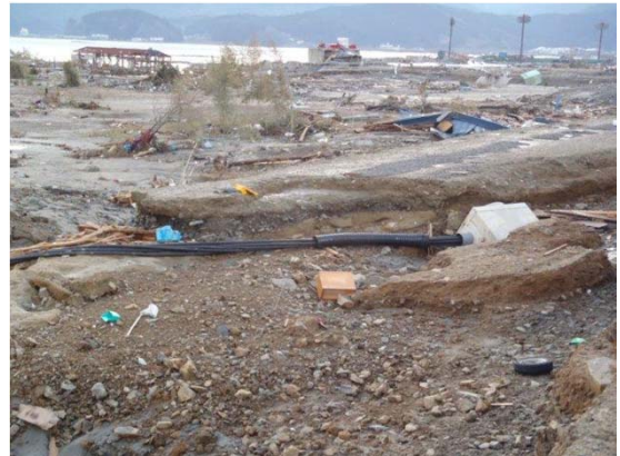
【R45 川原川橋付近】 情報管路被害 (三陸国道(事))
