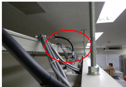
フレキシブル導波管に歪み有り
