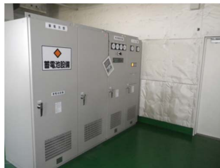
【鳴瀬川中流堰】（無停電電源装置） 装置、外観に異常なし
