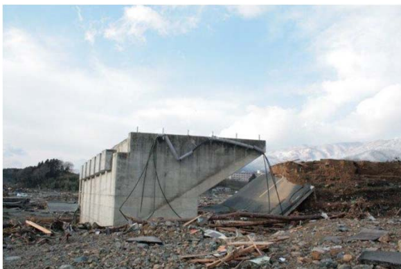
【R45 気仙大橋付近】 気仙町部望心 情報管路被害 (三陸国道(事))
