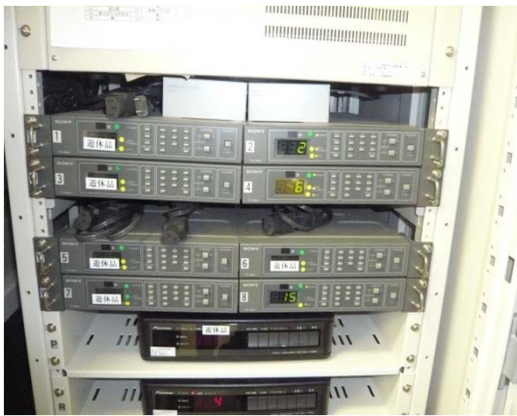
2台連結のチューナがV字に曲がっている。
