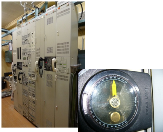
【岩沼河川局】 架が前傾している
