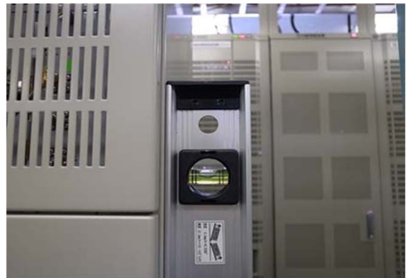
装置架列の水平状況に異常なし
