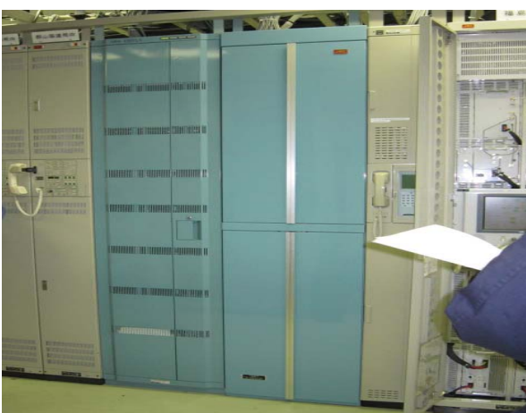
【笹森山無線中継所】 装置架の状況に異常なし
