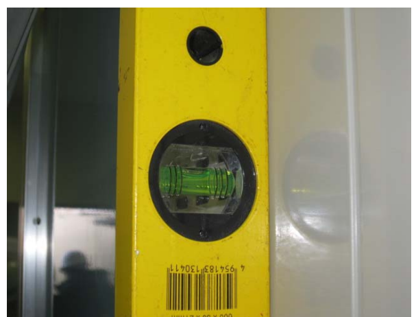
装置架列の水平状況に異常なし
