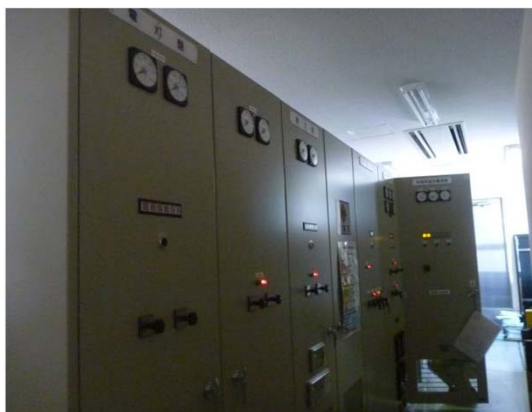
【三陸国道事務所】 異常なし
