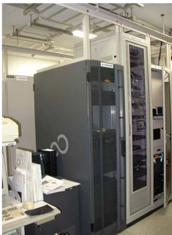
【三陸国道】 情報機器架においても架上部を 固定している。
