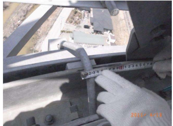
他方向向け空中線においても移動した形跡有り
