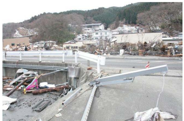
【R45 川原川橋付近】 情報管路被害 (三陸国道(事))
