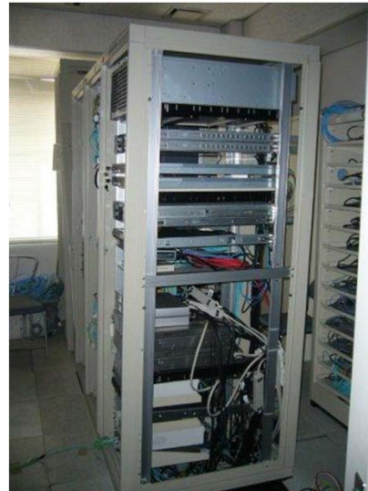
【郡山局】 道路情報処理装置：大きく右に傾斜
