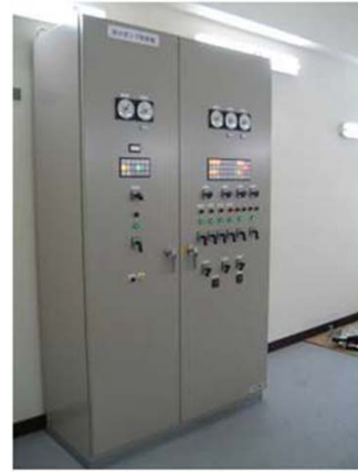
【仙人トンネル第2電気室】 消火ポンプ制御盤 配水本管引出口 盤扉ゆがみ(開閉動作が困難)
