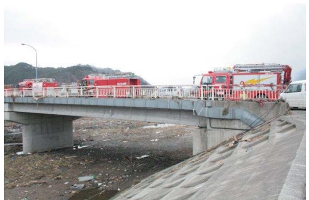
【R45 大浜渡橋】 耐火防護が被害を軽減 (三陸国道(事))
