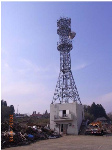
【気仙沼国道】 局舎2F床上 1900mm位まで浸 水した形跡有り。
