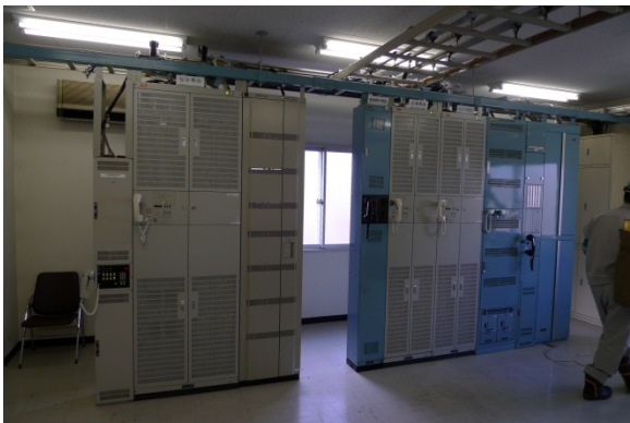
【青葉山局】 立架状況 異常なし
