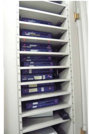
サーバ等が耐震固定されていないもの有り
