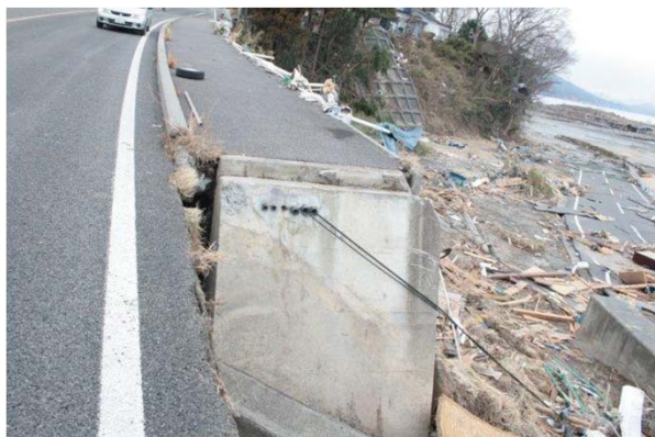
【R45 吉里吉里海岸付近】 情報管路被害 (三陸国道(事))
