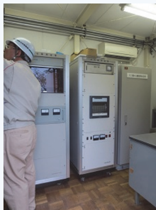
局舎内部 水位観測装置の移動・損傷は見られない
