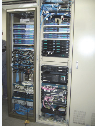
CCTV監視制御装置 内部状況 外観上の異常は見られない
