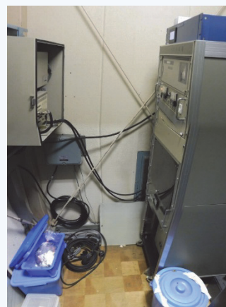
水位計の状況。損傷や不具合は見られない
