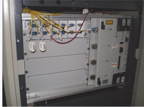
光ファイバ線路監視装置（支線系） ファイバ障害は検出しているが装置自体は問題なし
