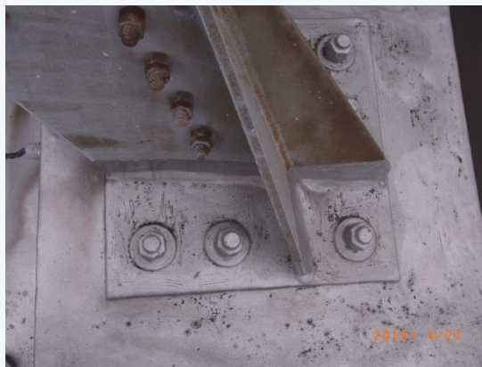
鉄塔基部 アンカーボルト、基部に損傷は認められない。
