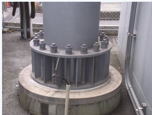
鉄塔基部 アンカーボルト、コンクリート基部に不具合ヶ所は見られない。
