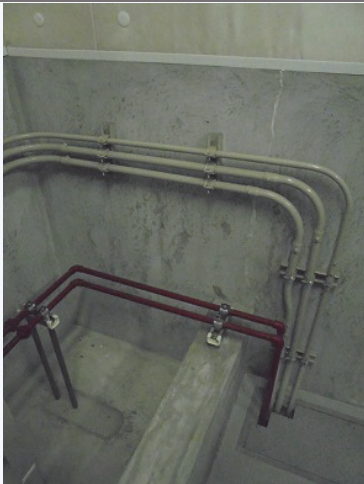
燃料小出槽の配管に歪み、ねじれ無し
