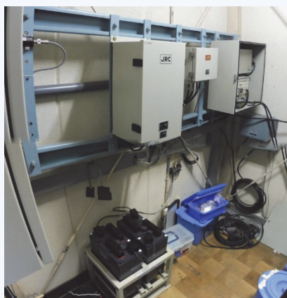
テレメータ観測装置の状況。損傷や不具合は見られない
