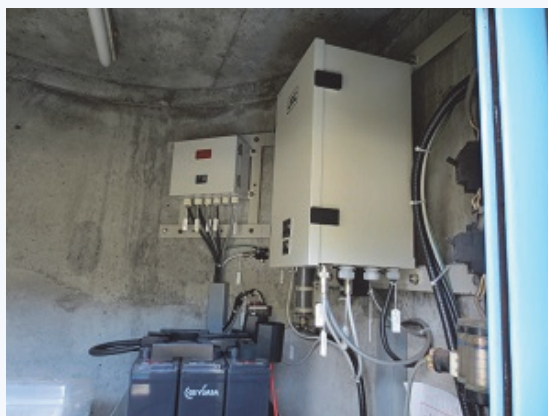
雨量局塔内 外観上の問題は見られない
