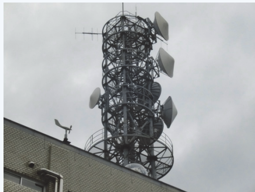
空中線 外観 異常なし。
