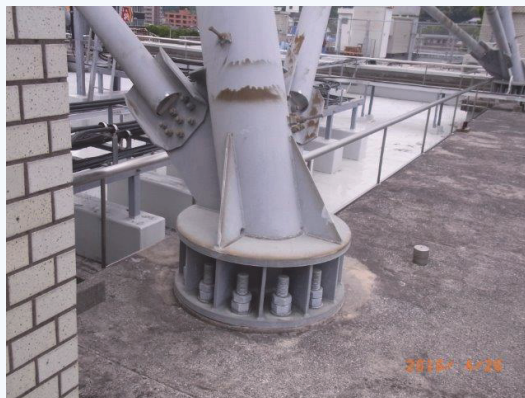
屋上鉄塔 鉄塔基部に変形、移動等の痕跡は見られない。
