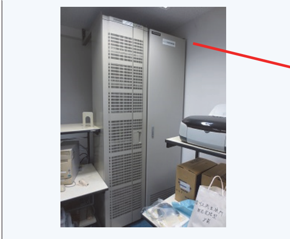
CCTV監視制御装置 外観上の問題は見られない
