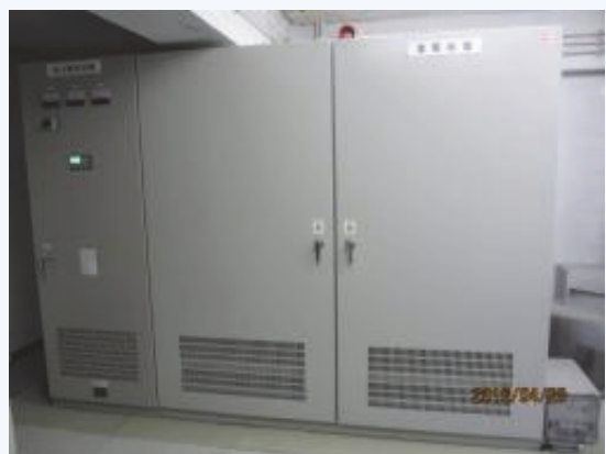
直流電源装置、蓄電池盤 装置の損傷は見られなかった。
