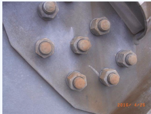
最下部の斜材取付け部 緩み、ずれ等の痕跡は見られない。
