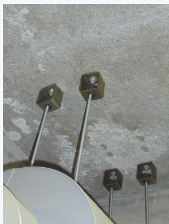
消音器のインサート、吊り金物に歪み無し
