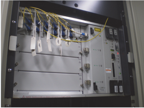
光ファイバ線路監視装置（本線・幹線系） ファイバ障害は検出しているが装置自体は問題なし
