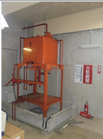
小出槽の据付位置、天井吊り金具など異常無し
