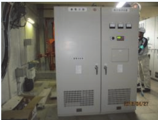
直流電源装置 装置の損傷は見られなかった。
