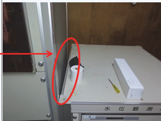
水位観測装置 装置架が移動した形跡が見られる
