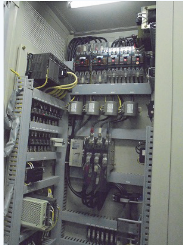
盤内部に部品の欠落、破損など無し
