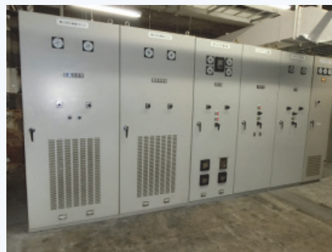
動力変圧器盤 (No. 2)、電灯変圧器盤 (No. 2)、高圧受電盤、コンデンサ盤、電源切替盤、直流電源盤 装置の損傷は見られなかった。
