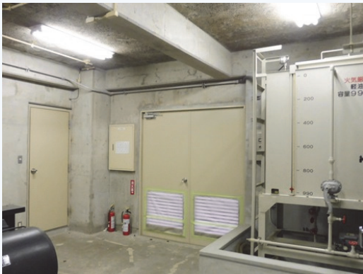
1 F 発電機室 ひび割れは、みられない
