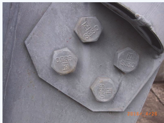
最下段の斜材接合部
