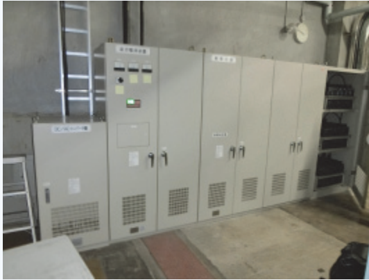
DC-AC インバータ盤、直流電源装置、蓄電池盤 装置の損傷は見られなかった。
