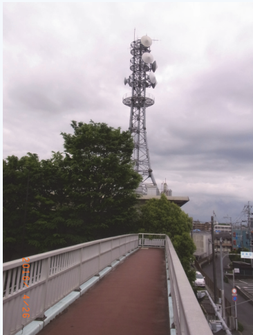
鉄塔全景 目視確認による不具合は見られない。
