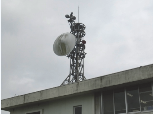
空中線 外観 異常なし。
