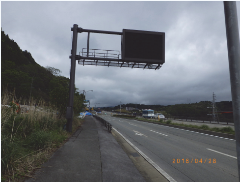
NHL 2形表示機 全景 基礎部、F型支柱、情報板本体に構造的な異常は見られない
