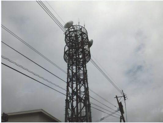
空中線 外観 異常なし。
