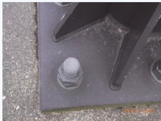
河川情報板 アンカーボルト 緩み、ずれ等の痕跡なし
