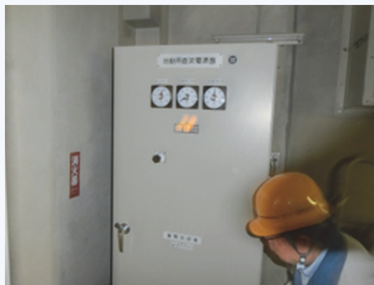
発電機始動用直流電源盤 装置の損傷は見られなかった。
