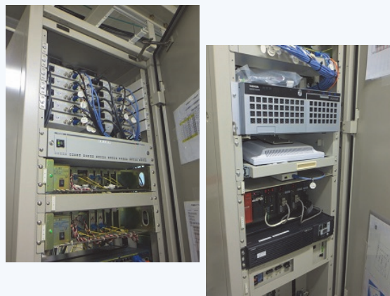
CCTV制御装置1 内部状況 内部実装機器も外観上の問題は見られない
