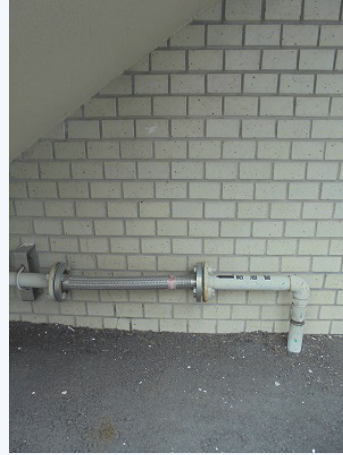
地下タンクからの給油管に歪み、ねじれ無し
