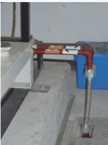
配管に歪み、ねじれなど異常無し
