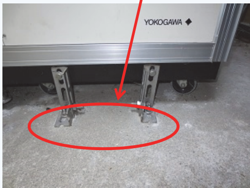
水位観測装置 主装置脚部のボルトが緩んでいた
