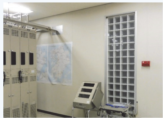
2 F 無線機室 ひび割れは、みられない
