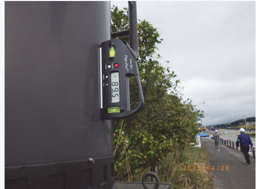
立野情報板 F型支柱 F型柱に傾きはない
