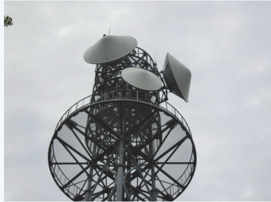
空中線 外観 異常なし。
