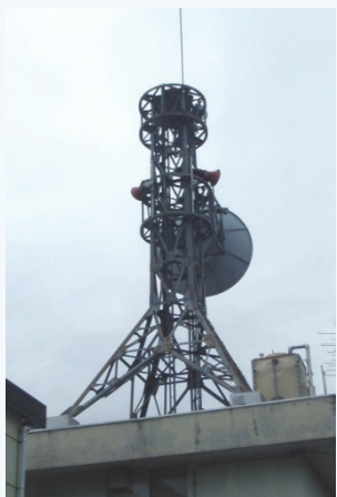
鉄塔全景 損傷は見られない。
