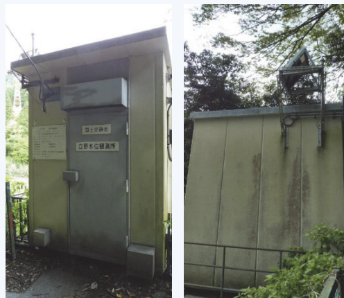
局舎 壁面や構造に外観上の問題は見られない
