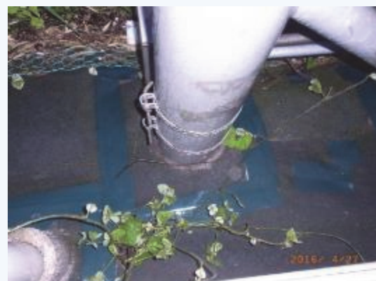
門型柱基部 (A 2 形正面視左側) 法面に張った雑草防止シートで確認することはできないが、大きな隙間等は生じていない模様
