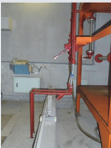
配管に歪み、ねじれなど異常無し
