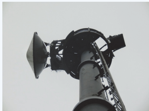
空中線 外観 異常なし。
