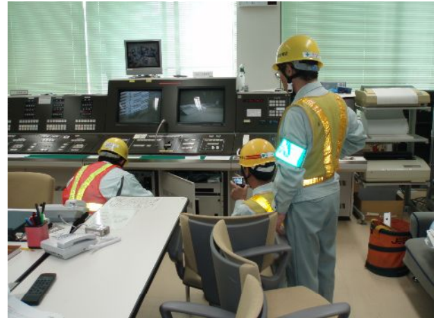
ダム放流設備制御装置調査 (石澗ダム)
