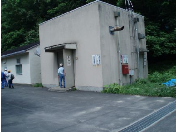
予備発電設備調査（石渕ダム）
