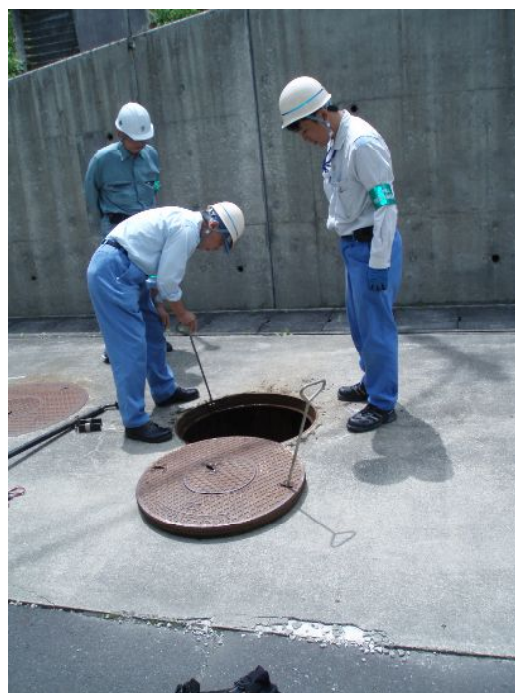
燃料地下タンク調査（鳴子ダム）
