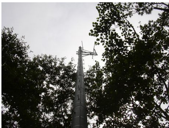
(5) 大歩水位観測所設備調査
