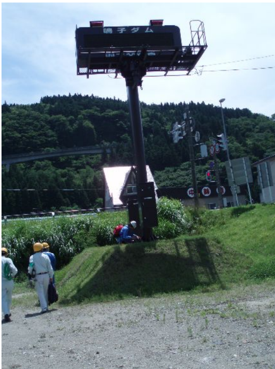
(2) 上鳴子放流警報表示板調査 （鳴子ダム）
