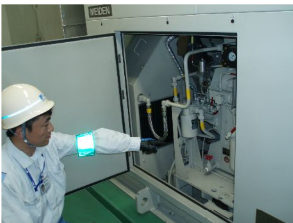
予備発電設備調査（鳴子ダム）
