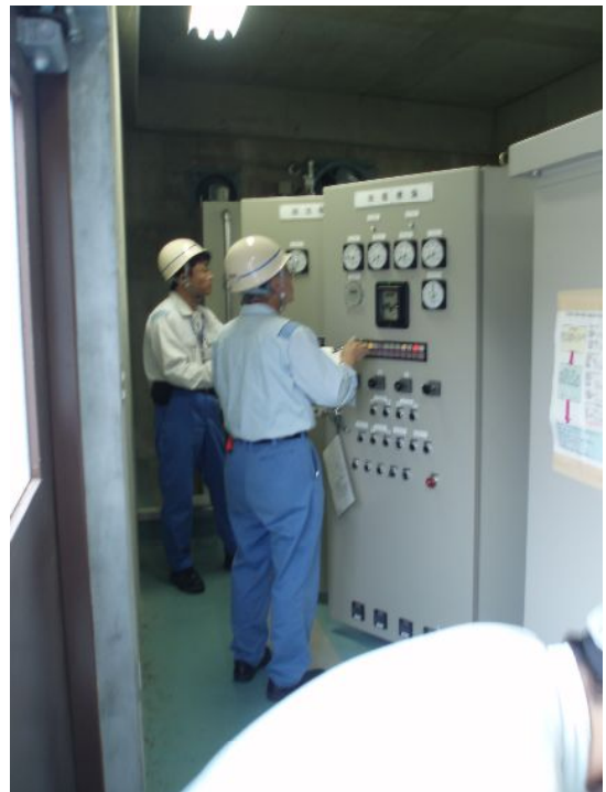
受変電設備調査 (胆沢ダム)
