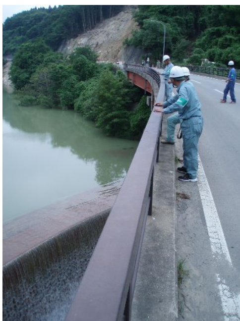
(7) 矢櫃ダム被災状況視察 (岩手県管理)
