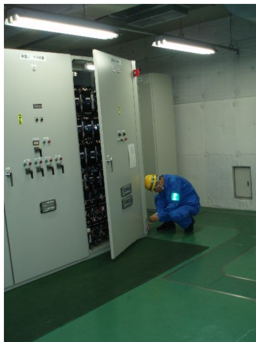
受変電設備調査（鳴子ダム）
