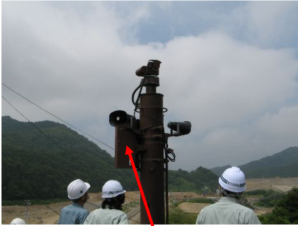
カメラ本体が運台から脱落
