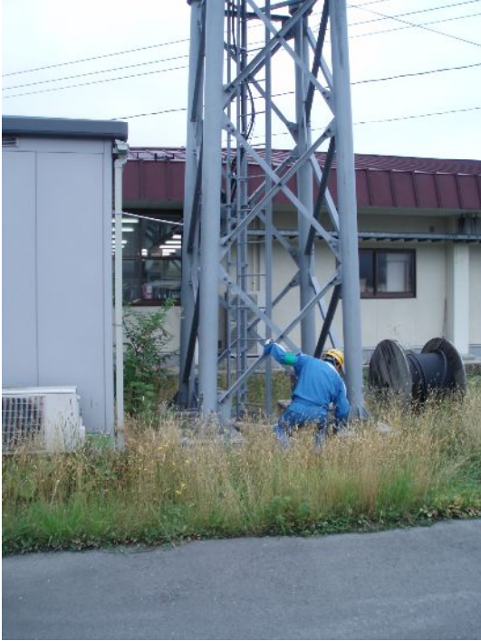
鉄塔調査 (胆沢ダム)
