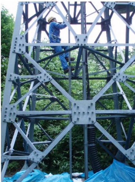
鉄塔調査（石湫ダム）
