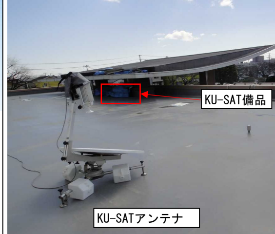
役場2階ベランダにKu-SATアンテナを設置
