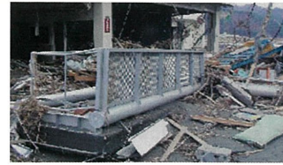
写真-3 R45(218.9KP上り) 片岸道路情報板本体流出
