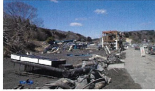
写真-5 R45(256.7KP下り) 金浜道路情報板倒壊
