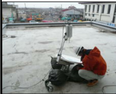
TEC-FORCE隊員による衛星通信機器設営
