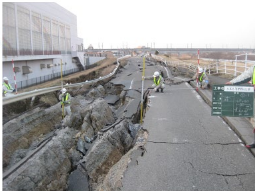
・江合川の緊急復旧状況(宮城県大崎市福沼地先)
