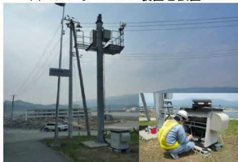
川口カメラへFWA装置を設置
