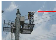
川口カメラへFWA装置を設置
