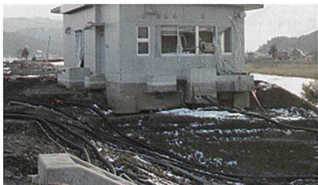
写真-13 月浜第一水門電気室建屋周辺表土流出(北上川河口)
